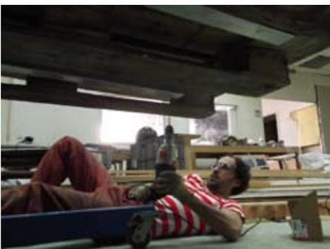
renforcement de la structure avec des vis dans l'épaisseur et des cornières métalliques
